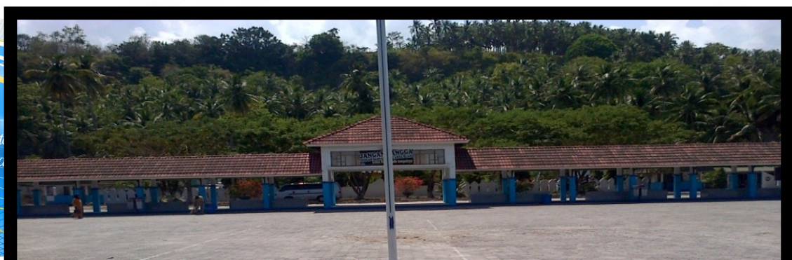
Gambar 1.16 Area Parkir dan Peron Kedatangan/Keberangkatan Terminal Angkutan Darat Benteng
