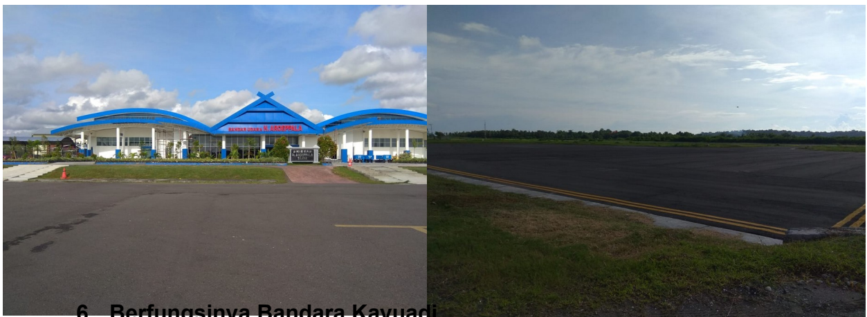
Gambar 1.14 Area Parkir Pesawat ( Apron ) Bandara H. Aroeppala
